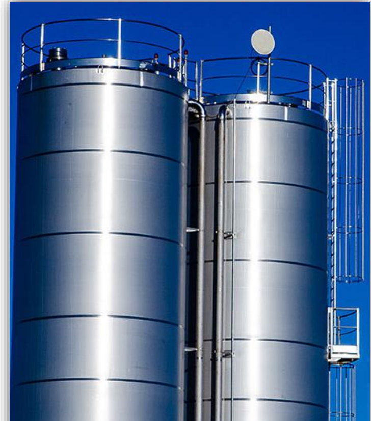
SISTEMA DE SILOS PARA RESINA
