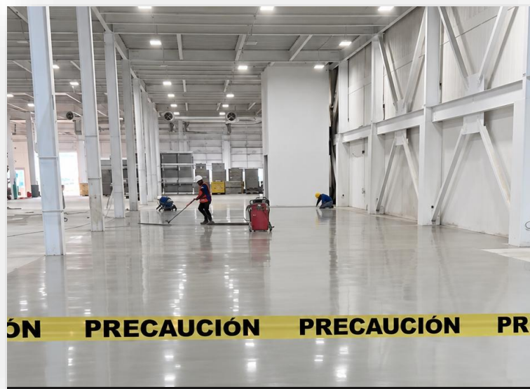
PISO EPÓXICO AUTO NIVELADO
