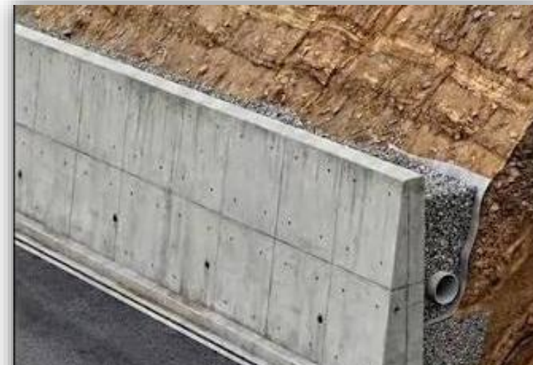
MURO DE CONTENCIÓN
