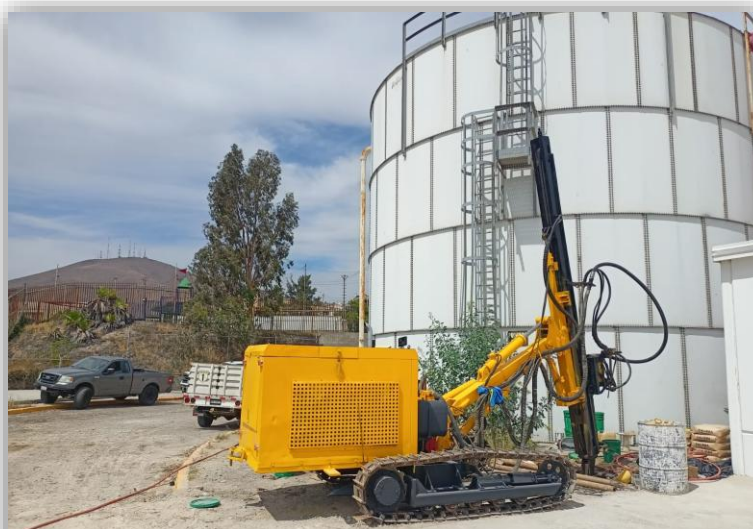
SISTEMA DE MICRO PILAS
