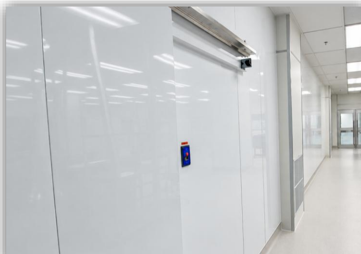
MURO CON RECUBRIMIENTO FRP
