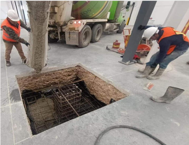
Construcción de Zapata
