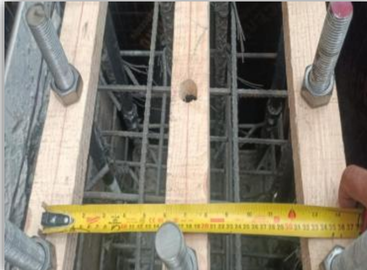
Alineación de Anclas de Soporte
