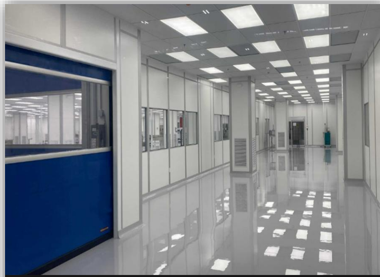
CUARTO DE TRANSFERENCIA
